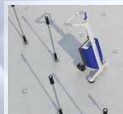
6. Befestigungspunkte mit der Dachbahn verschweißen
