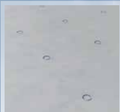
4. Befestigungspunkte auf der Dachbahn markieren
