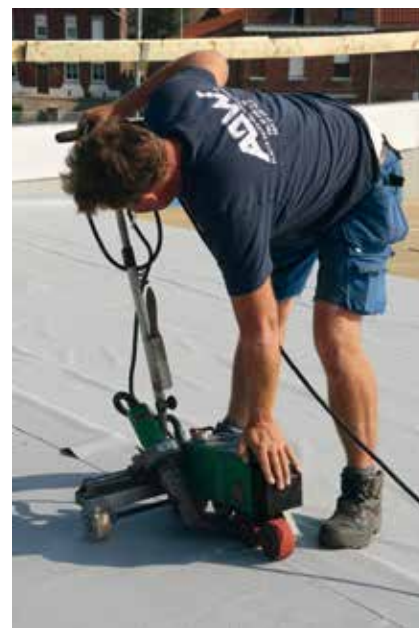
Het voorboren in de betonnen ondergrond en het dichtlassen van de naadoverlappen met hete lucht
