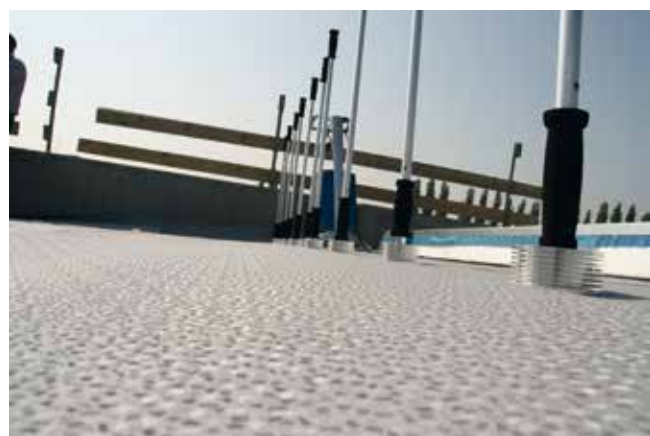
Het hier gebruikte Protan SE PVC membraan is duidelijk herkenbaar aan de antislip oppervlakteprofieling
