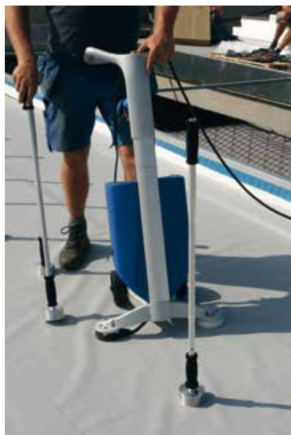
Wanneer het geluidssignaal aangeeft dat de inductielas klaar is wordt er kort een magneet op geplaatst om nog wat druk uit te oefenen en voor een snellere afkoeling te zorgen
