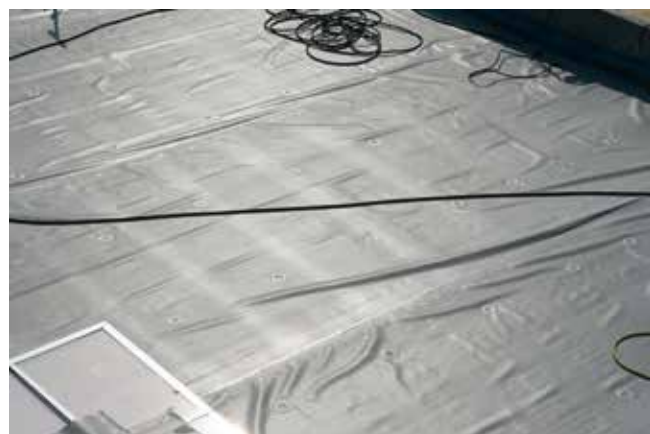
De rondjes in de afgewerkte dakbedekking vormen een extra visuele controle dat alle lassen goed zijn uitgevoerd
