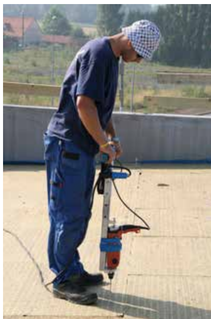
Het voorboren in de betonnen ondergrond en het dichtlassen van de naadoverlappen met hete lucht
