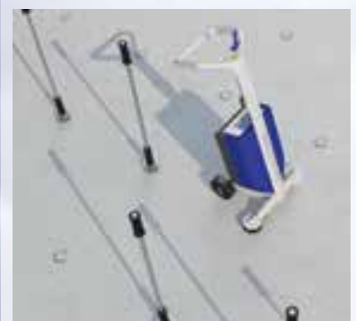
6. Befestigungspunkte mit der Dachbahn verschweißen
