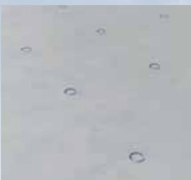
4. Befestigungspunkte auf der Dachbahn markieren
